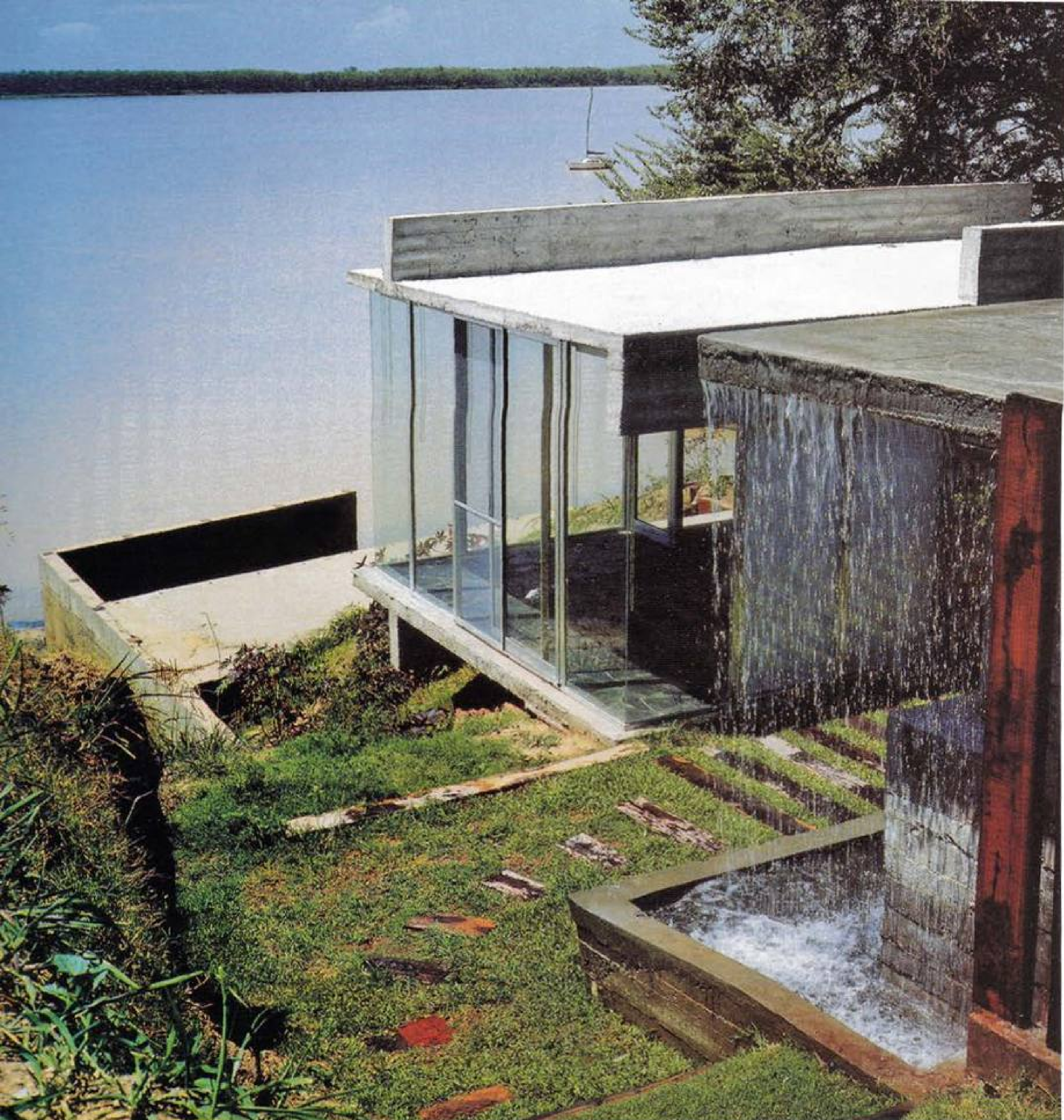
Casa en Barranca del Río Paraná, Arroyo Seco.
